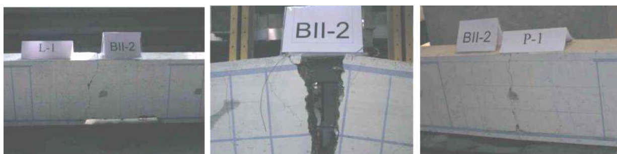
Rys. 12. Obraz zniszczenia belki BII-2 w przekrojach charakterystycznych.
